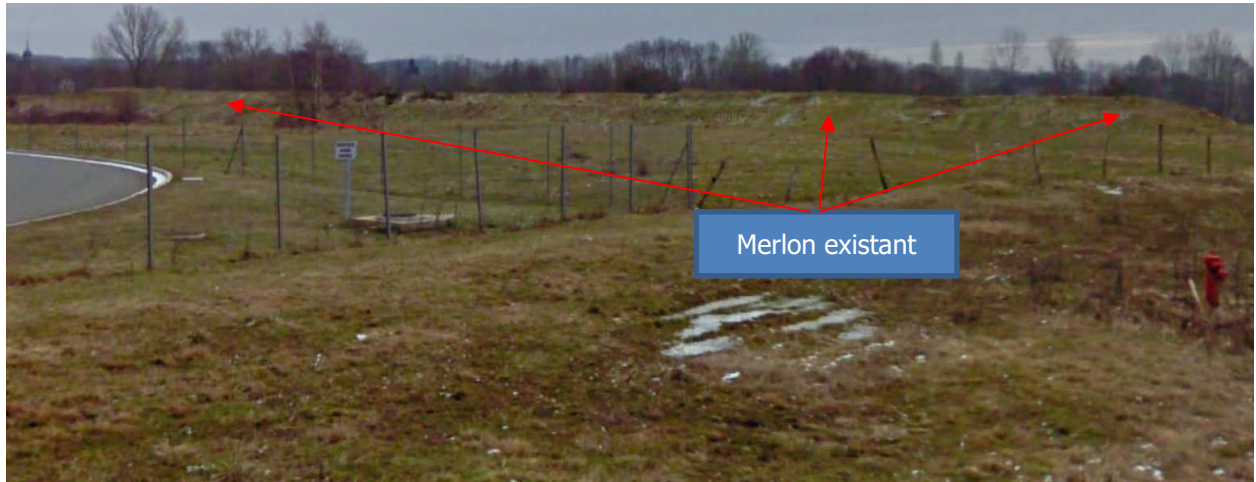
Figure 6 : vue sur le merlon existant (source google street view)
